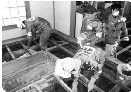
【5月12日～15日（ボランティア派遣）】 東播磨ブロックから60名のボランティアを募り、気仙沼市で泥かき作業等を行った。
